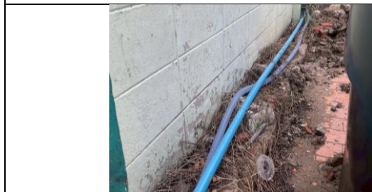
รูปที่ ผ7.2 ท่อระบายน้ำชั่วคราวรอบพื้นที่ก่อสร้าง
